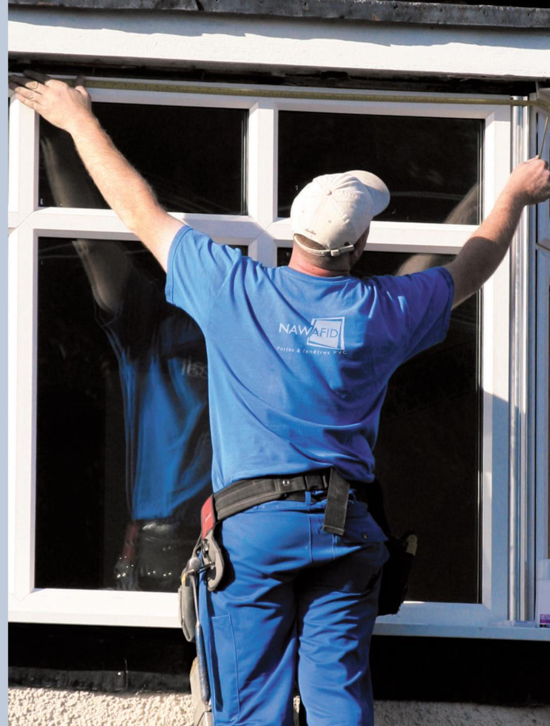
La pose des menuiseries PVC se fait en tableau sur le gros œuvre, c'est-à-dire sur la face latérale de la baie.
